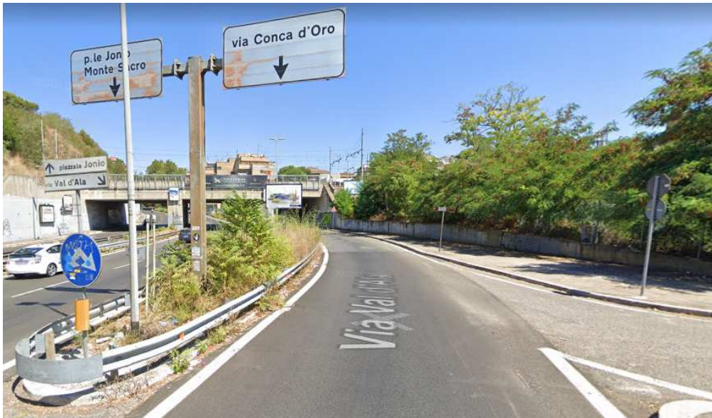
Vista della viabilità
