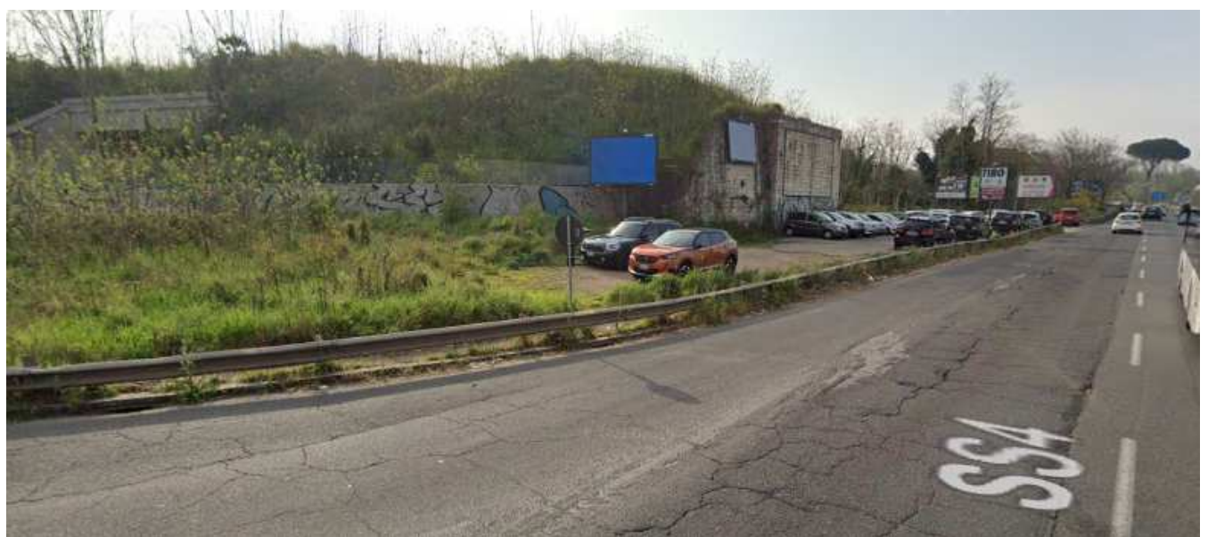
Vista della viabilità
